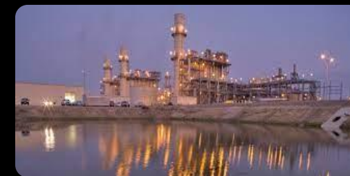
Centrais de energia
